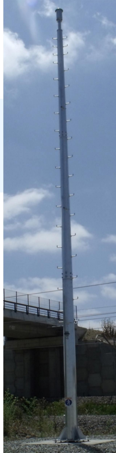
■ Detalle mástil poligonal 15 m.
