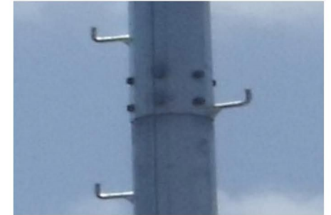
■ Detalle unión tramos atornillados y pates soldados.
