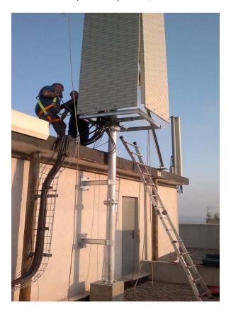
4º Mediante la sierra de calar, se realizarán un corte para que el arriostramiento se pueda fijar al mástil existente.
